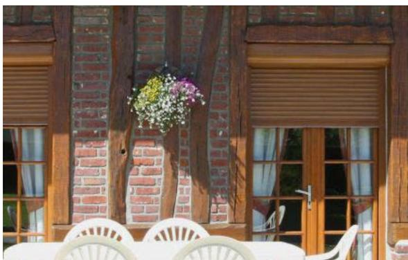
Le volet roulant rénovation est un volet conçu sur mesure et adapté à des fenêtres et ouvertures, qui au départ n'ont pas été prévues pour accueillir des volets roulants. La pose de ce type de volet ne modifie en rien la maçonnerie de votre fenêtre ou votre porte.
