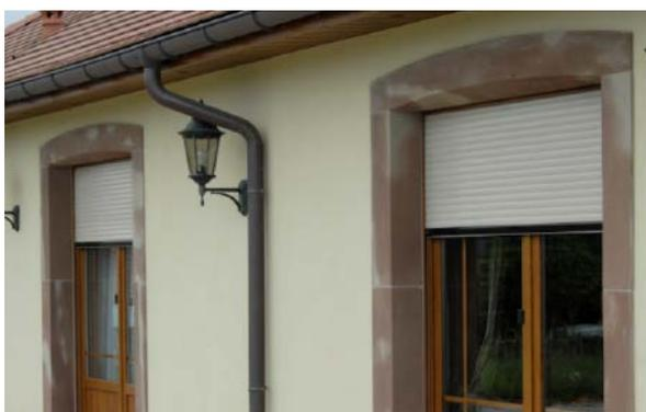
Le volet monobloc / bloc baie est posé en même temps que la fenêtre, c'est en fait la dernière génération des volets roulants. Sa grande innovation réside dans le fait qu'il s'adapte à tous type de construction neuve ou en rénovation.
